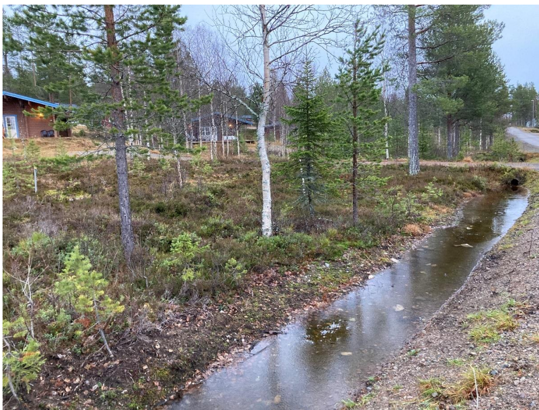
Figur 15. Befintliga dikessystem i området med fördröjningsvolym.
