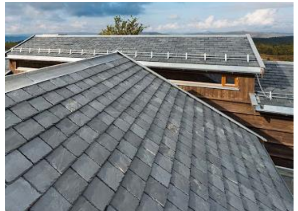
Skiffer är ett naturligt takmaterial som lämpar sig väl i fjällmiljö. (Bild från Google)
