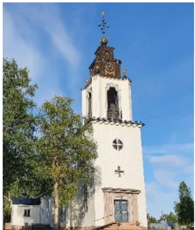
Idre kyrka uppfördes 1933 (Bild från Google.)
