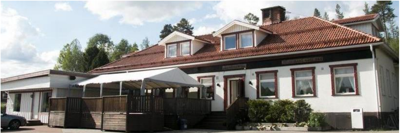
Byvägen 30 är en äldre byggnad från tidigt 1900-tal som idag inhyser restaurang och logi. (Bild från Google)
