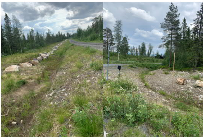
Figur 4: Befintliga diken inom området (Bild: Sweco).
