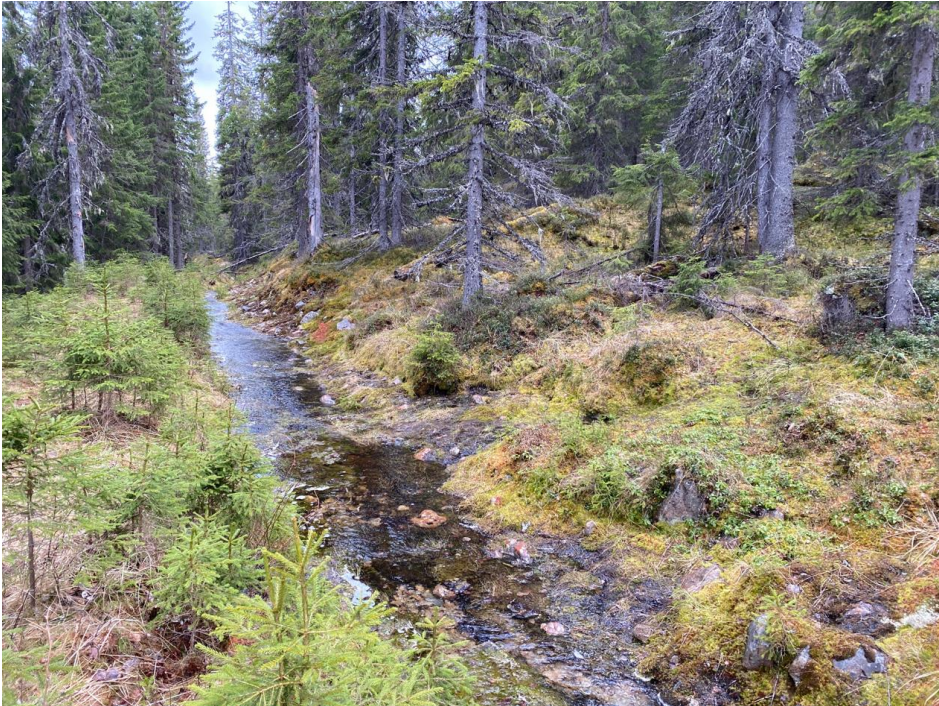
Figur 12 Grävt dike i moränmark.
