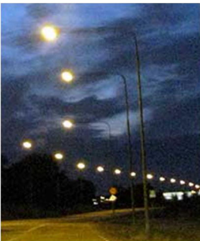
Över genomfartens vägbana sitter belysningspunkterna högre med gult ljus. Det gula ljuset skapar kontrast som markerar tung trafik.
