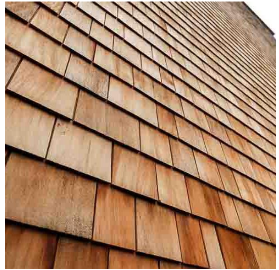
Obehandlade träfasader kan ges olika utformning och de blir vackrare med tiden.
